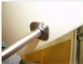
Рисунок 5.8: Отверстие для подпирающего стержня в крышке
